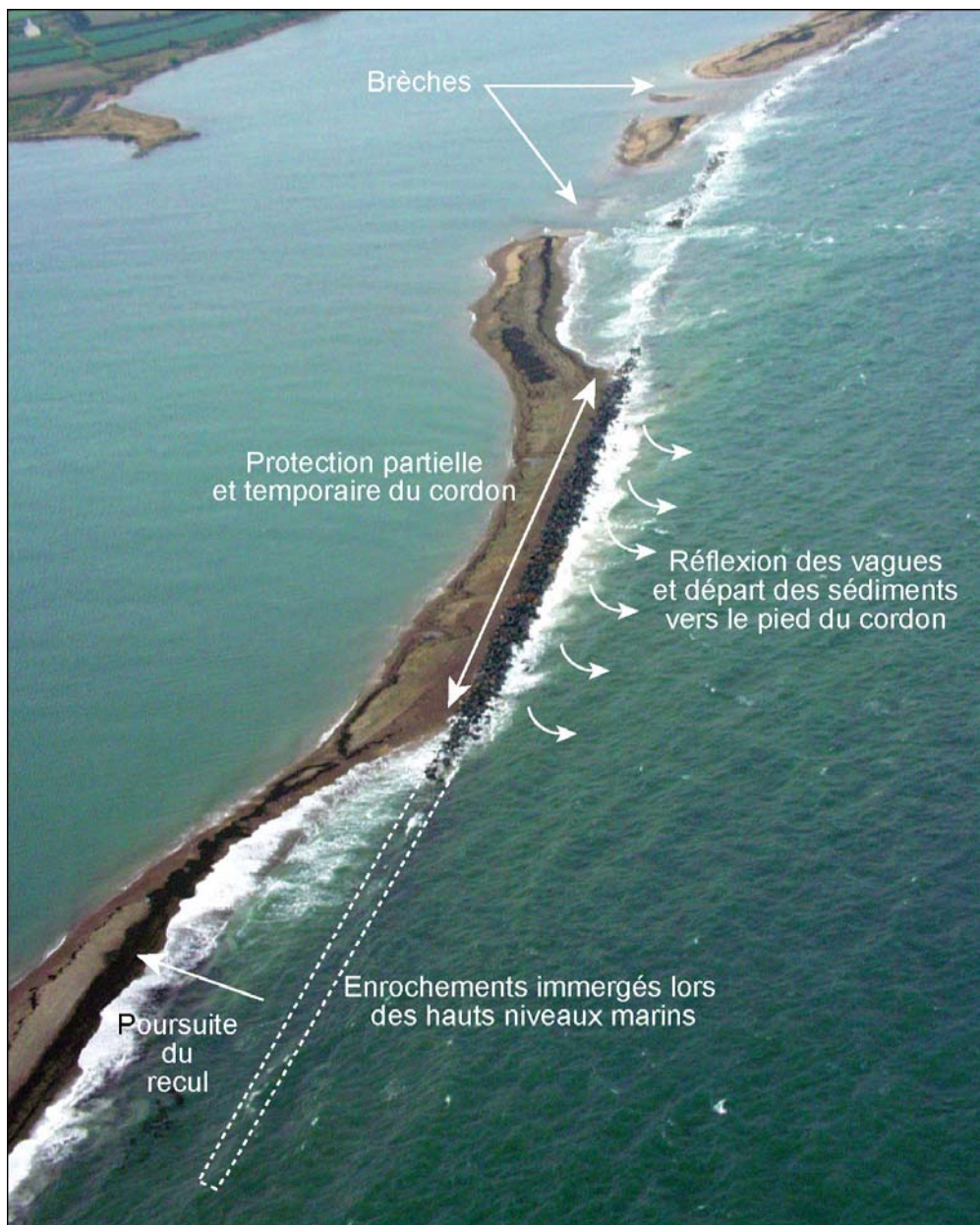
Figure 163 : Effets perturbateurs de l'enrochement longitudinal sur le fonctionnement morphosédimentaire du Sillon de Talbert lors des phases de haut niveau marin (cliché : C. Bonnot-Courtois, 19/09/01).
