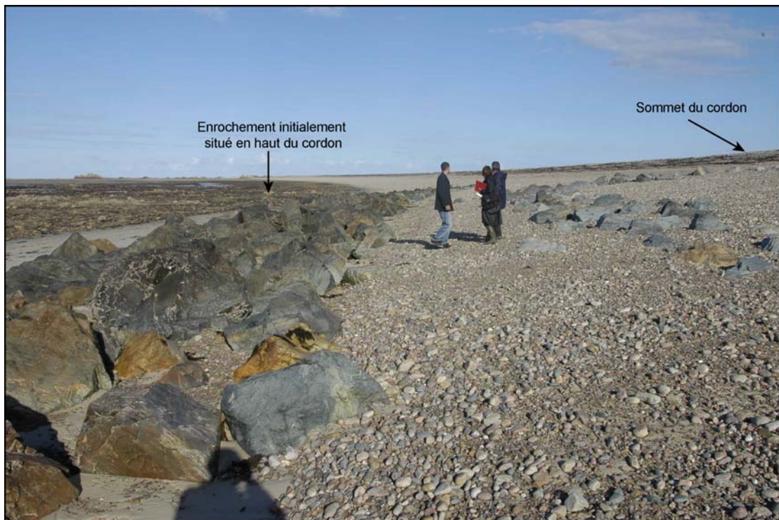
Figure 247 : Enrochement au pied du Sillon de Talbert (Cliché : D. Halleux, octobre 2004).
