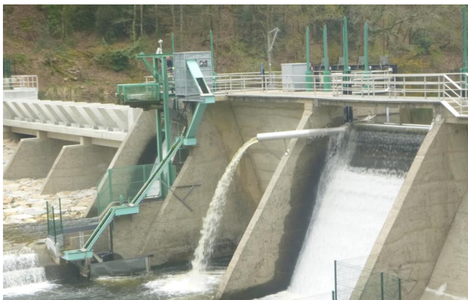
Figure 3 : Passe à anguille de Tréauray vue d'aval
