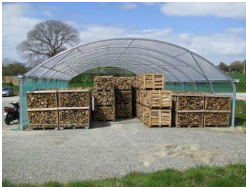
Figure 30 : tunnel de séchage du bois de l'ESAT de Glomel
