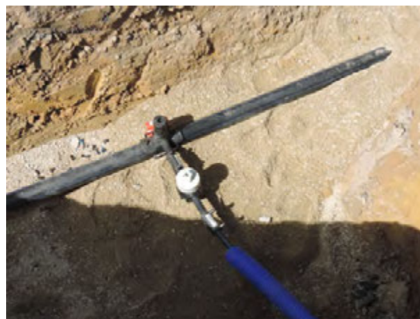
Travaux de renouvellement de canalisations et branchements Avenue du Maréchal Leclerc - Mordelles Avril 2017
