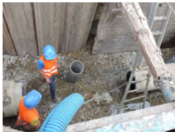
Inspection caméra pour vérifier l'intérieur de la canalisation Boulevard Malakoff - Rennes 19 juillet 2017
