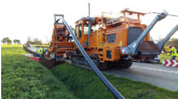
Renouvellement d'une conduite en PEHD 200 mm par trancheuse - RD 70 - Irodouër Novembre 2017
