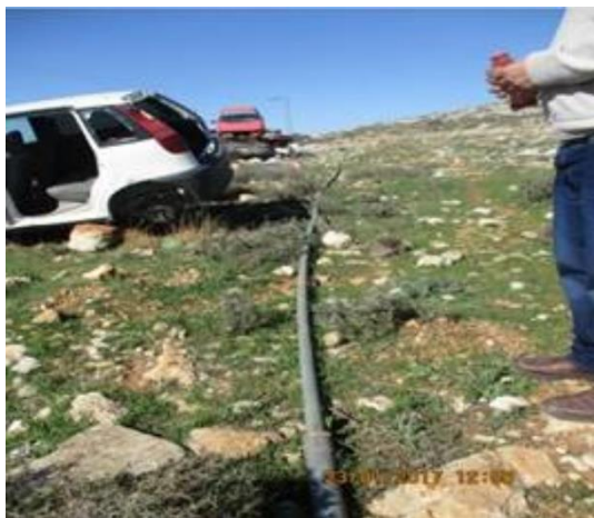
Beitunia, un réseau de distribution à même le sol et en mauvais état
