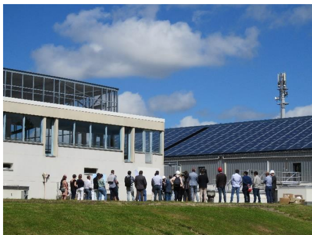
Point Presse pour la réception des travaux de l'usine de Villejean à Rennes
