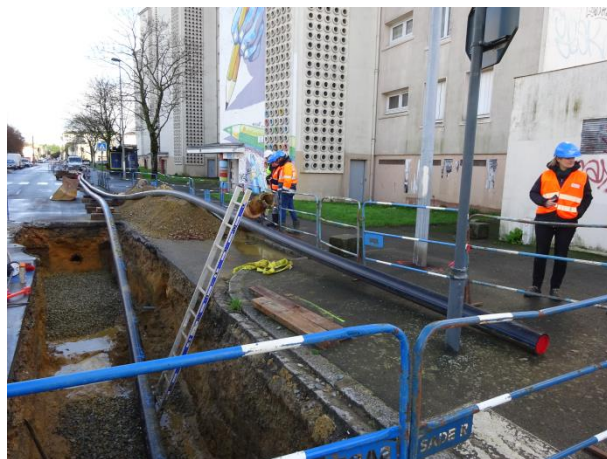
Travaux de renouvellement d'une canalisation d'eau potable Rue Champion de Cissé - Rennes Décembre 2018
