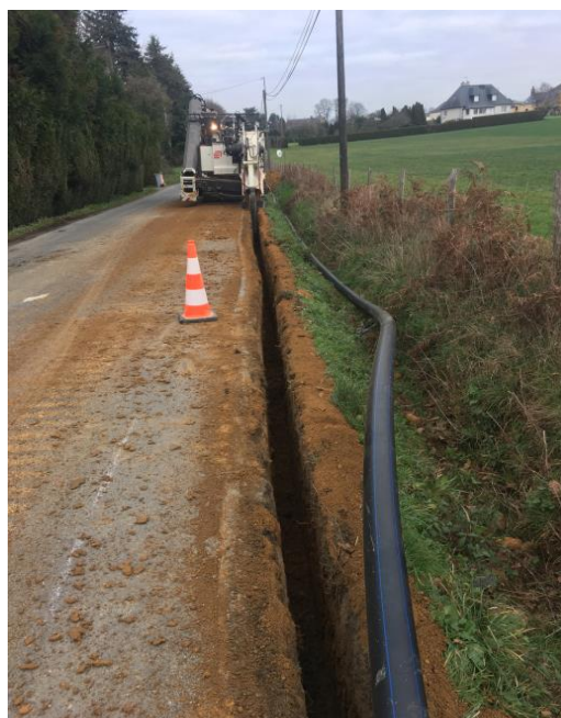
Renouvellement d'une conduite en PEHD 125 mm par trancheuse Tihouit - VC 5- Betton Décembre 2018
