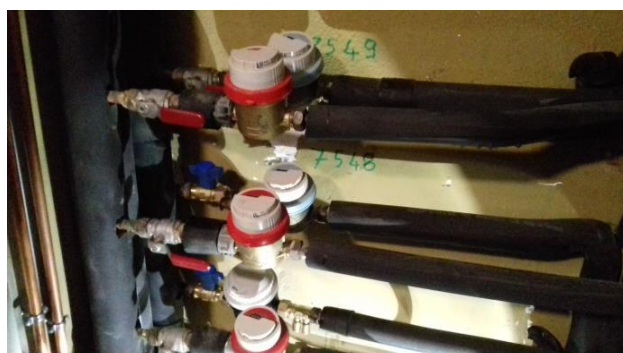
Individualisation des consommations d'eau froide dans un immeuble Rue de Dinan - Rennes
