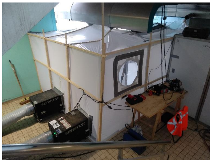
Désamiantage : dispositif de sas pour le désamiantage des anciennes jardinières amiantées :
