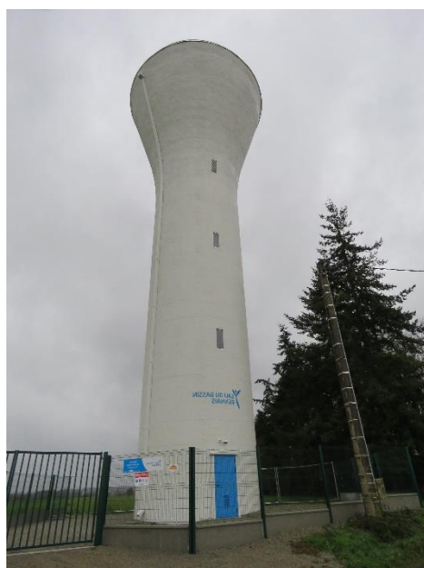
Réhabilitation du réservoir de Saint-Armel
