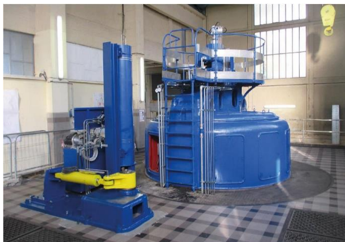
Vue du groupe de production hydroélectrique après réhabilitation (alternateur et régleur)
