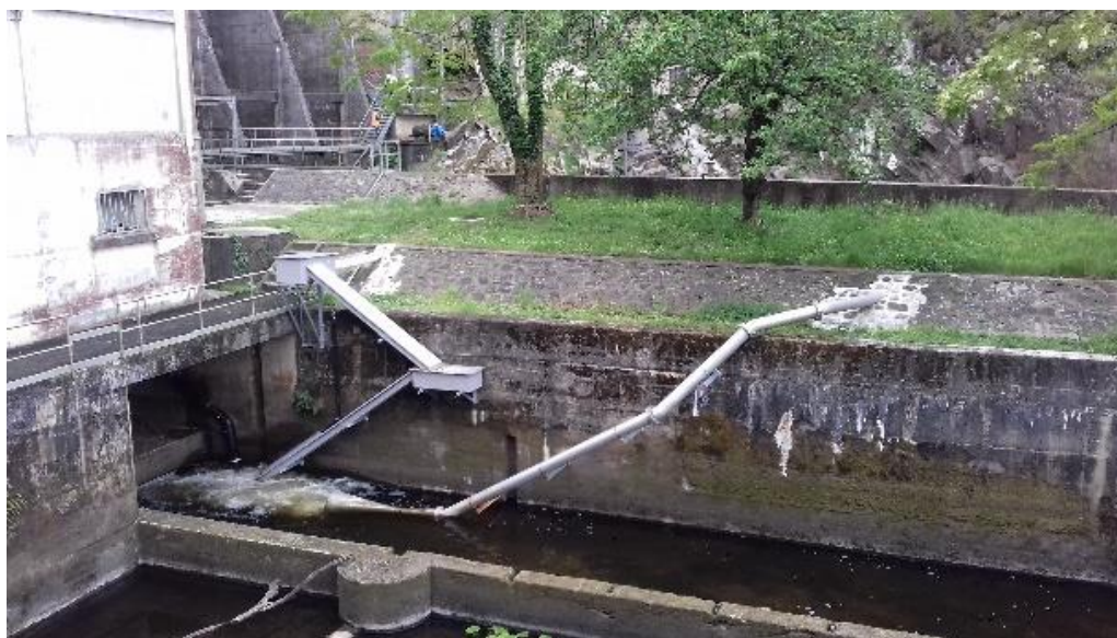
Vue de l'amorce du dispositif de montaison et de l'exutoire de la dévalaison
