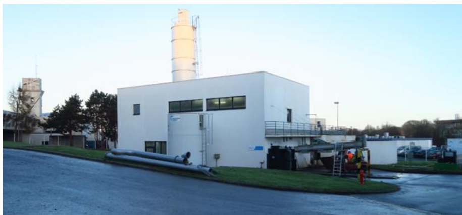
L'actuel bâtiment de traitement des boues
