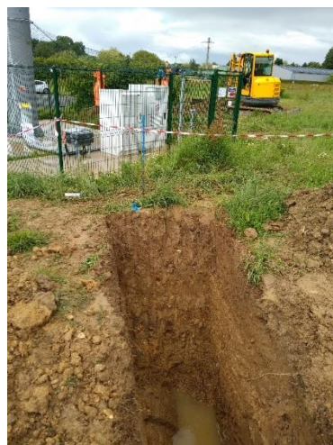
Sondage adduction Rophémel au droit du Pylône
