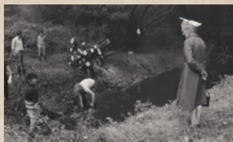
Inspection du chantier...
