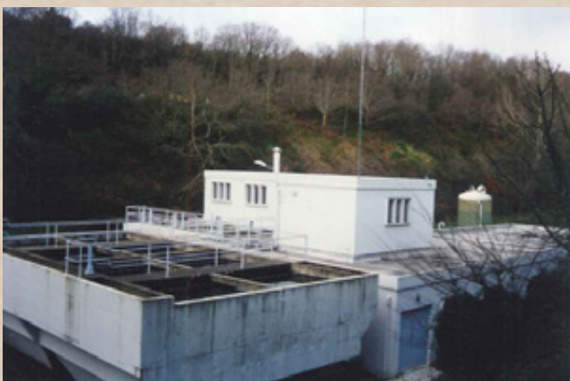
Dénitrater les eaux : une impasse que condamne la commission européenne (usine de dénitratisation de Binic).
