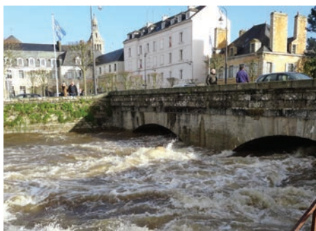
Pont du Bourgneuf lors des crues de 2013/2014 (06/02/2014)
