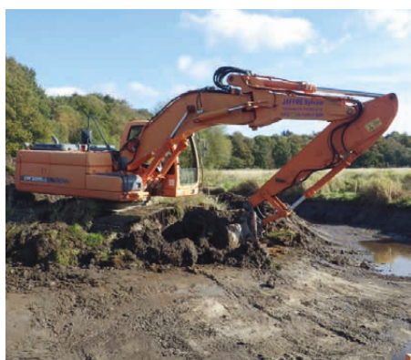
Création d'un méandre sur l'Ellé à Langonnet
