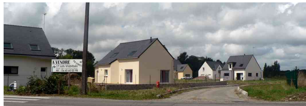
Émergence de nouveaux lotissements le long des axes et en périphérie des bourgs, sans logique particulière d'un point de vue implantation de bâti, orientation...
