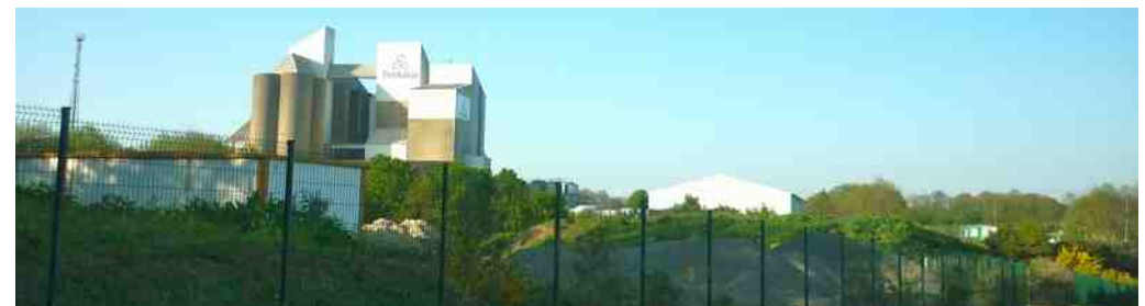
De grandes infrastructures agricoles, industrielles ou de conditionnement rythment le paysage
