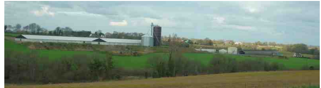
Implantation de bâtiments agricoles avec silos imposants
