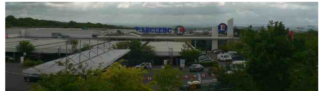
Intégration réfléchie d'un bâtiment commercial le long de la RN 165
