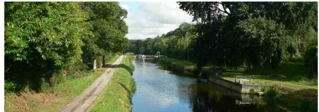
Le paysage structuré du Canal de Nantes à Brest
