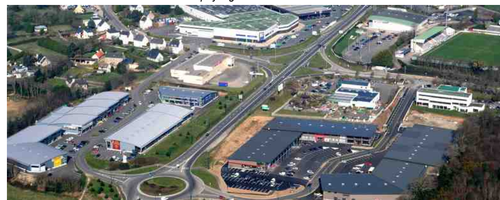
Développement des zones d'activités et des infrastructures routières sur la commune de Concarneau Source : Jean-Pierre Ferrand
