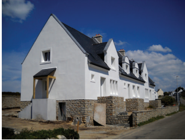
Vue extérieure de l'ancien immeuble des gardiens de phares
