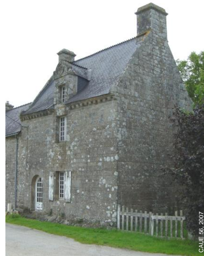
① Ancien bâtiment sur la route de Silfiac à Séglien Gros œuvre : murs en moellons granitiques ; encadrements en granite taillé ; couverture en larges pierres d'ardoise
