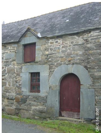
③ Ferme en Cléguérec (18 ème siècle) Gros œuvre : murs en pierres de schiste et moellons gréseux ; encadrements en grès vert
