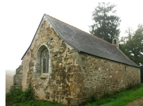
⑦ Chapelle St-Marc en Bréhan (17 ème siècle) Gros œuvre : murs en pierres de schiste, roussards et moellons gréseux ; encadrements en granite taillé ; chaînage en granite et roussards ; enduit encore visible sur les murs extérieurs
