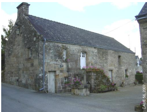
⑥ Maison d'habitation en Quelven (Guern) Gros œuvre : murs en pierres de taille et moellons granitiques ; encadrements en granite taillé
