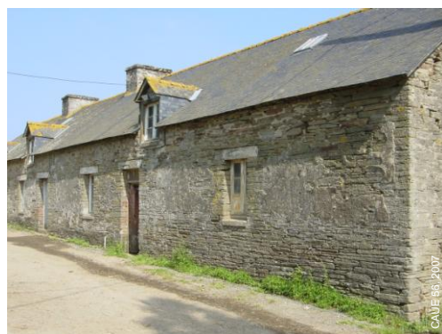
④ Ferme en Kersuho (Remungol) Gros œuvre : murs en pierres de schiste ; enduit encore visible sur la façade
