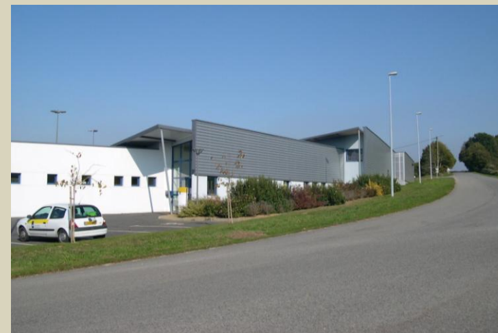
Parc d'activités La Niel à Noyal-Pontivy, bâtiment sobre épousant les formes du relief
