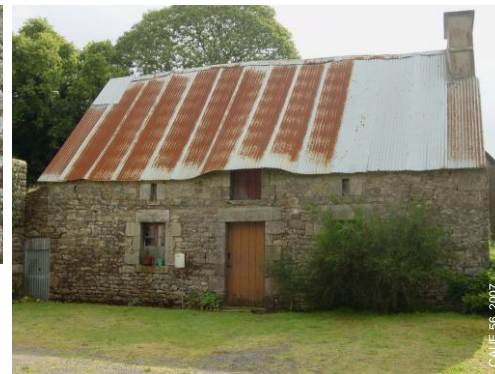
⑤ Bâtiment en St-Just (Bignan) Gros œuvre : murs en moellons granitiques ; encadrements en granite taillé
