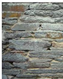
① Anciennes Forges des Salles en Ste-Brigitte (19 ème siècle) Gros œuvre : murs en pierres de schiste ; encadrements en granite taillé
