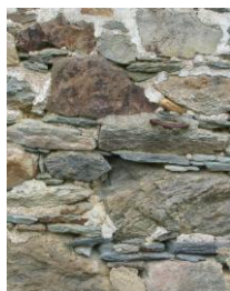
③ Ferme en Cléguérec (18 ème siècle) Gros œuvre : murs en pierres de schiste et moellons gréseux ; encadrements en grès vert
