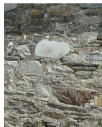
② Maison d'habitation en Malvran (St-Aignan) (19 ème siècle) Gros œuvre : murs en pierres de schiste et grès
