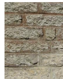
⑧ Maison de bourg en Plumelec Gros œuvre : murs en pierres de taille granitiques
