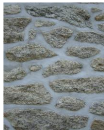
⑦ Maison de bourg en Moustoir-Ac Gros œuvre : murs en moellons granitiques ; encadrements et chaînage en granite taillé
