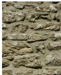
③ Chapelle Notre-Dame-du-Moustoir en Malguénac (16 ème siècle) Gros œuvre : murs en pierres de taille et moellons granitiques ; encadrements et chaînage en granite taillé
