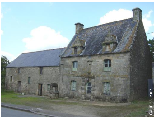
⑨ Maison d'habitation dans le bourg de Bieuzy Gros œuvre : murs en pierres de taille et moellons granitiques ; encadrements et chaînage en granite taillé
