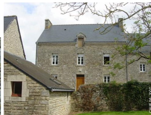
⑩ Maison de bourg en Guéhenno Gros œuvre : murs et encadrements en pierres de taille granitiques
