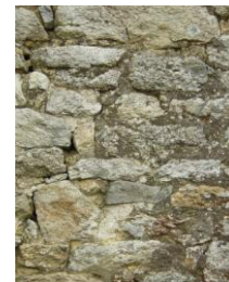
⑤ Bâtiment en St-Just (Bignan) Gros œuvre : murs en moellons granitiques ; encadrements en granite taillé
