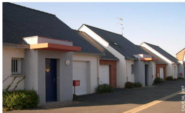
Logements récents construits dans le bourg de Kerfourm
