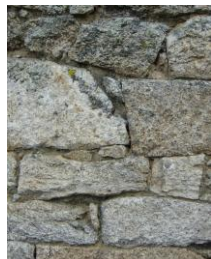
⑨ Maison d'habitation dans le bourg de Bieuzy Gros œuvre : murs en pierres de taille et moellons granitiques ; encadrements et chaînage en granite taillé
