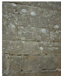
② Logis en Kergohan (Séglien) (17 ème siècle) Gros œuvre : murs et encadrements en pierres de taille granitiques
