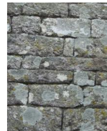
⑩ Maison de bourg en Guéhenno Gros œuvre : murs et encadrements en pierres de taille granitiques
