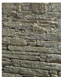
④ Ferme en Kersuho (Remungol) Gros œuvre : murs en pierres de schiste ; enduit encore visible sur la façade
