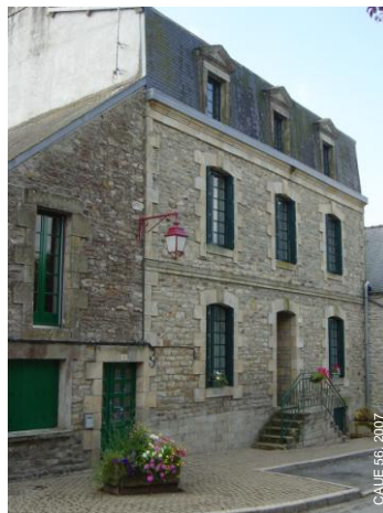
⑦ Maison de bourg en Moustoir-Ac Gros œuvre : murs en moellons granitiques ; encadrements et chaînage en granite taillé
