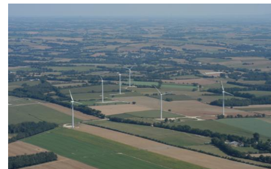
Centrales éoliennes sur les communes de Gueltas et Noyal-Pontivy
