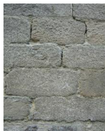
⑥ Maison d'habitation en Quelven (Guern) Gros œuvre : murs en pierres de taille et moellons granitiques ; encadrements en granite taillé
