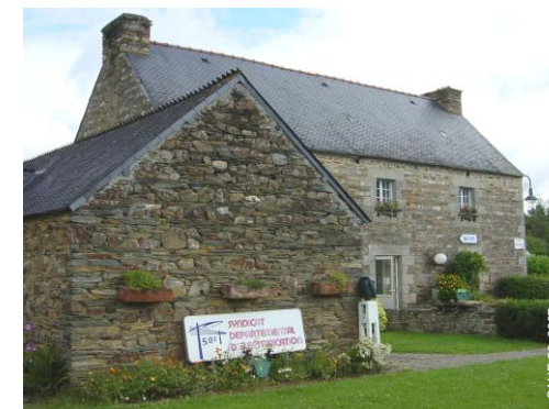
③ Musée de l'électricité en St-Aignan Gros œuvre : murs en pierres de schiste et grès ; encadrements en granite taillé
