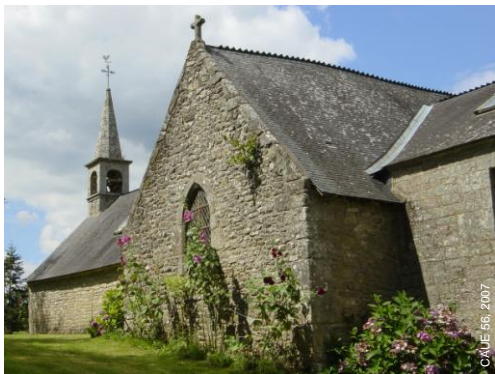
③ Chapelle Notre-Dame-du-Moustoir en Malguénac (16 ème siècle) Gros œuvre : murs en pierres de taille et moellons granitiques ; encadrements et chaînage en granite taillé
