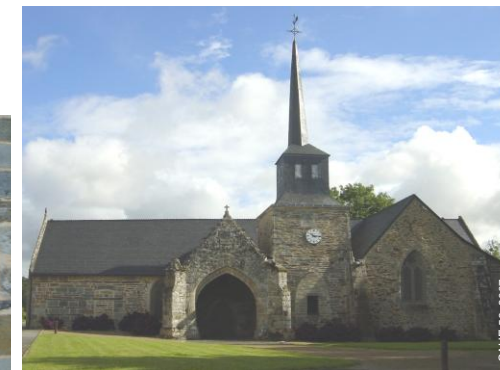
④ Eglise en St-Aignan Gros œuvre : murs en pierres de schiste et pierres de taille de granite et de grès vert ; encadrements en granite taillé
