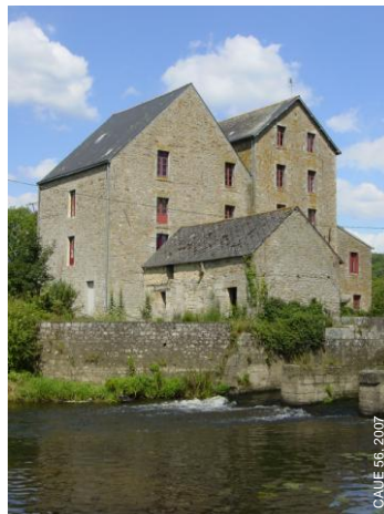
④ Minoterie en Baud Gros œuvre : murs en moellons granitiques
