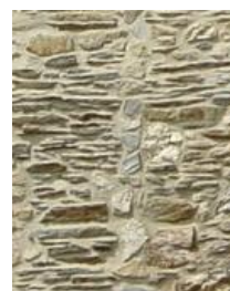
⑥ Maison de bourg en Radenac Gros œuvre : murs en pierres de schiste ; encadrements en granite taillé
