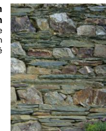
④ Eglise en St-Aignan Gros œuvre : murs en pierres de schiste et pierres de taille de granite et de grès vert ; encadrements en granite taillé
