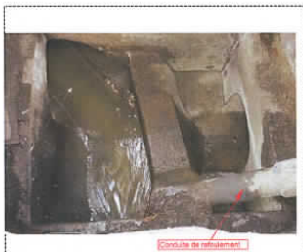
photo du déversoir d'orage
