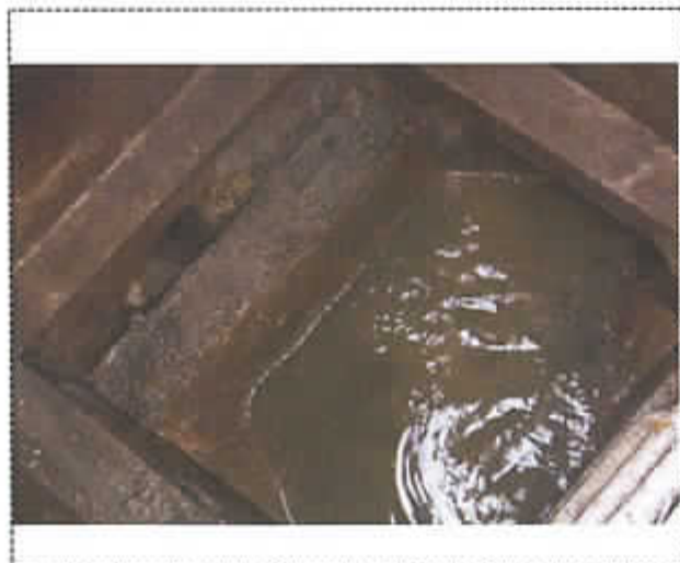
photo du déversoir d'orage
