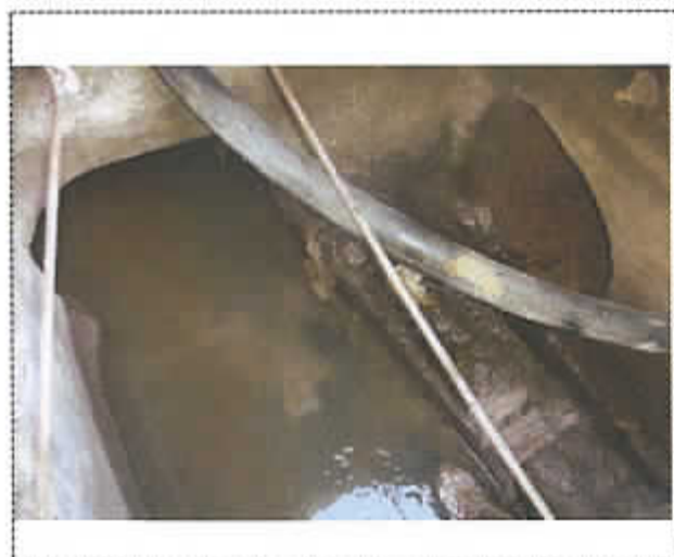
photo du déversoir d'orage
