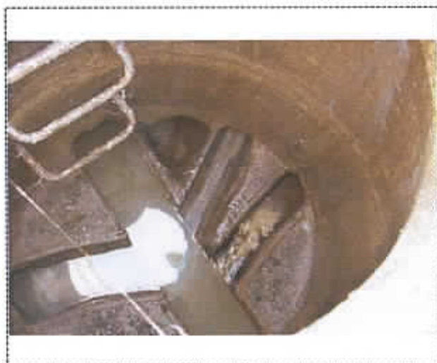
photo du déversoir d'orage
