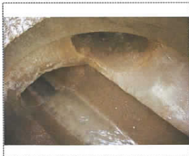
photo du déversoir d'orage
