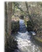
Ce seuil a été remplacé en rampe d'enrochement permettant de casser la marche.
