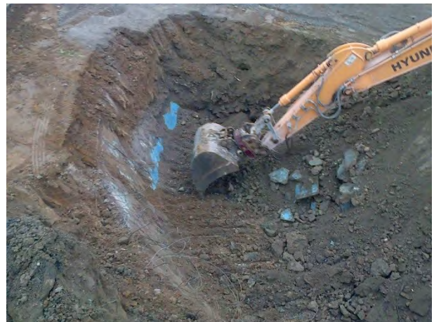
Usine de Villejean Démolition des fondations de cycloflocs 15 décembre 2016
