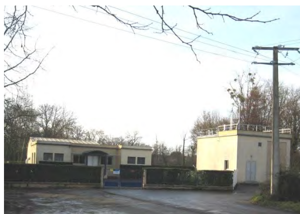
Vue générale de l'usine de Lillion
