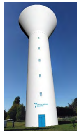
Photomontage du réservoir de Bruz réhabilité
