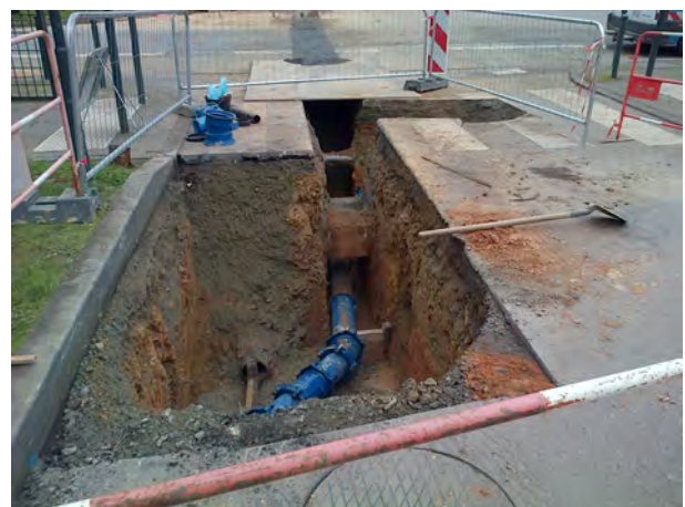
Renouvellement du réseau de distribution Boulevard de Bulgarie - Rennes Février 2016
