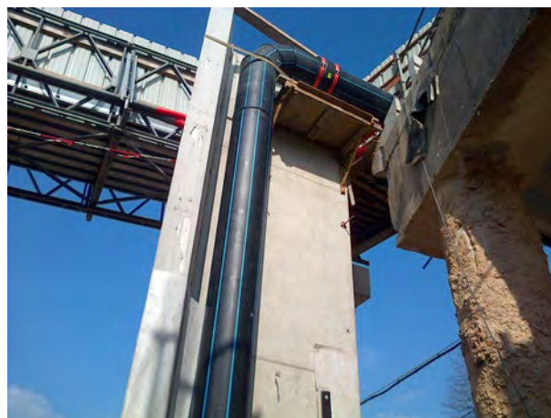
Pose d'une conduite d'eau potable en encorbellement CHU Pontchaillou - Rennes Mars 2016
