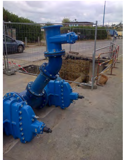
Vannage de diamètre 400 mm pour conduite de transport et alimentation en eau potable de la ZAC Baud-Chardonnet Rennes
