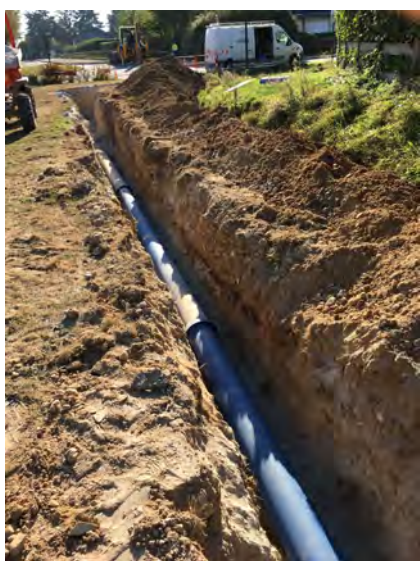
Travaux de sécurisation de l'alimentation en eau du Rheu Novembre 2016
