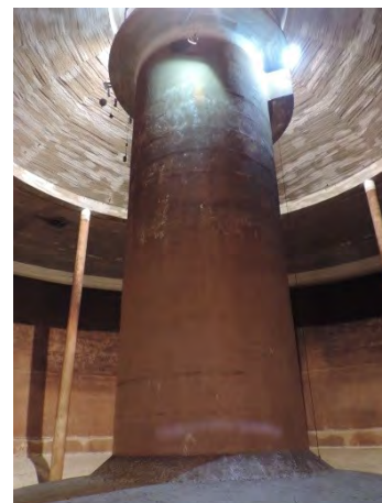
Cuve du réservoir sur tour des Gallets avant réparation
