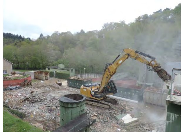
Usine de la Roche Déconstruction de l'ancien local chaux 2 mai 2016
