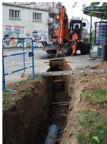
Travaux de renouvellement d'une conduite d'eau potable Route de Lorient—Rennes Mai 2016
