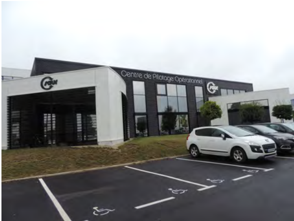
Centre de Pilotage Opérationnel de la SAUR situé à Vannes
