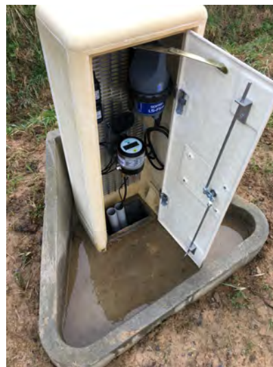
Compteur de séparation de réseaux posé fin 2016 à Chevaigné
