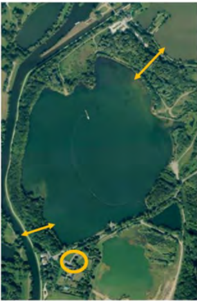
Étang des Bougrières Localisation des principaux travaux (vannes et aménagement de parking)
