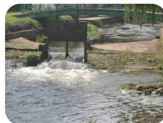
Lavoir d'Antrain : Seuil avant travaux
