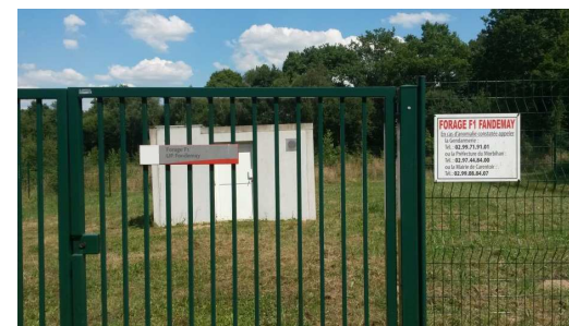
Périmètre de protection immédiate autour d'un forage
