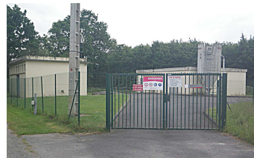
L'usine de production d'eau potable de Fondemay
