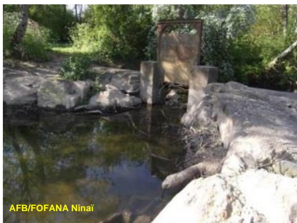
**La vanne de l'étang d'Alluchon avant démantèlement**
