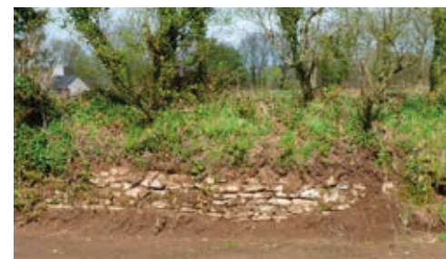
Un exemple de talus empierré (UP9, avril 2012).
