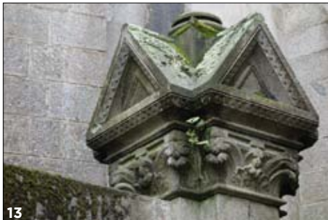
Fig. 8 - Colonnnette en kersantite, chaînage d'angle en granite de l'Aber-Ildud et assises en microgranite. Fig. 9 - Pied de colonne en leucogranite, colonne en kersantite, pierres de taille en granite de l'Aber-Ildud. Fig. 10 - Emmarchement du porche en granodiorite de Ploudaniel. Figs. 11, 12 et 13 - Kersantite claire utilisée pour les pilastres et sculptures (11 : porche / 12-13 : chevet).
