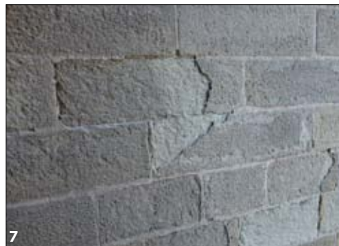
Figs. 3, 4, 5, 6 et 7 - Mise en œuvre du microgranite de l'île longue ; 3 et 4 : en façade ; 5 : en assises basses des murs ; 6 : teinte et texture typique en association avec du granite de l'Aber-Ildut ; 7 : desquamation fréquente.
