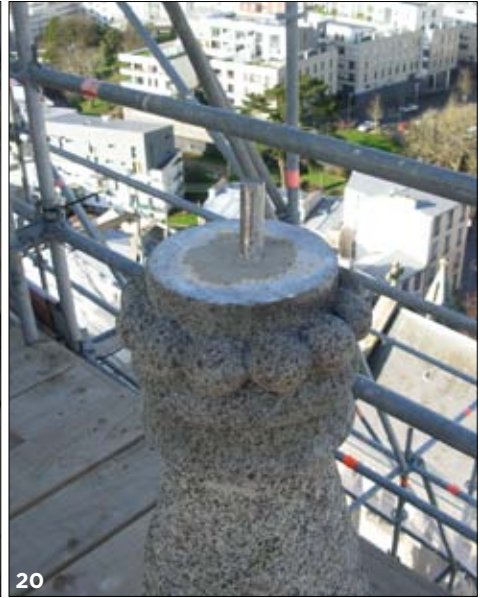
Fig. 20 - Goujon inox, base du fleuron couronnant les clochetons.
