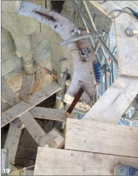
Fig. 19 - Ancre métallique dans la base d'un clocheton.
