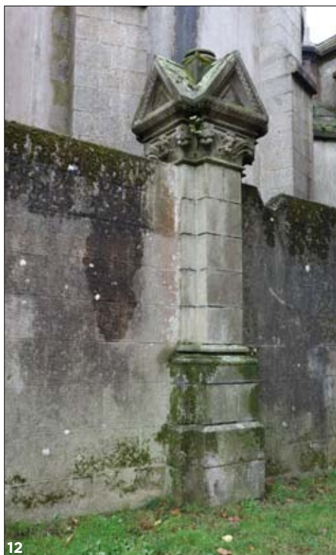
Fig. 8 - Colonnnette en kersantite, chaînage d'angle en granite de l'Aber-Ildud et assises en microgranite. Fig. 9 - Pied de colonne en leucogranite, colonne en kersantite, pierres de taille en granite de l'Aber-Ildud. Fig. 10 - Emmarchement du porche en granodiorite de Ploudaniel. Figs. 11, 12 et 13 - Kersantite claire utilisée pour les pilastres et sculptures (11 : porche / 12-13 : chevet).
