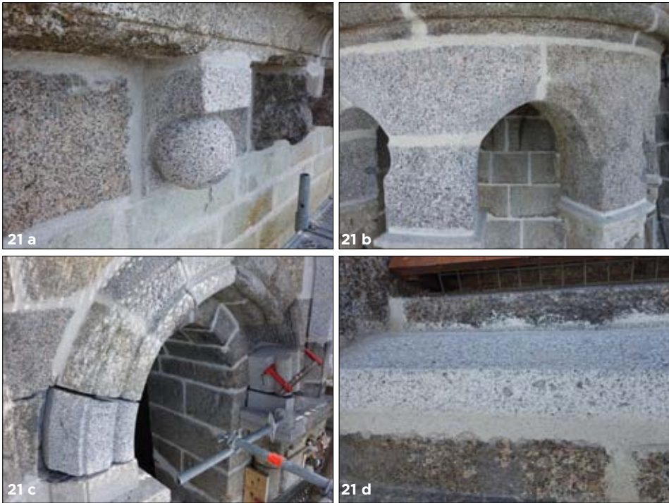
Fig. 21 - Remplacement de pierres taillées (a,b,c : granite de l'Aber-Ildut ; d : granite du Huelgoat).
