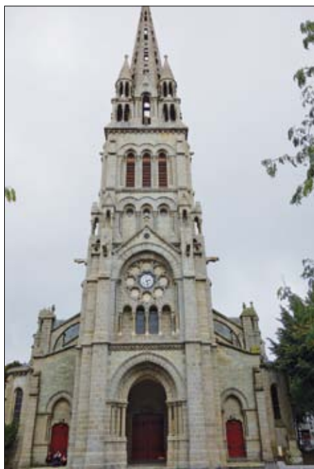
Travaux de restauration de l'église Saint-Martin terminés.
