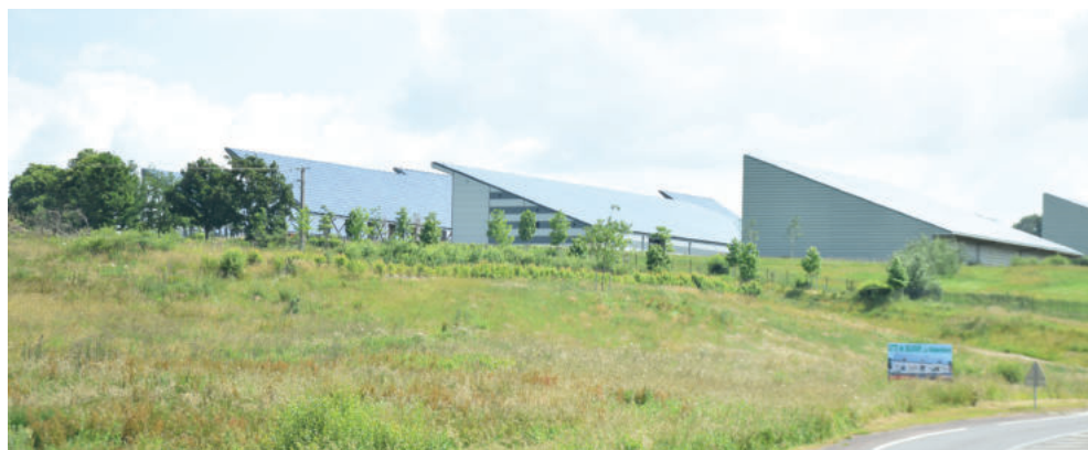
Bâtiments de l'écoparc recouverts par des toitures photovoltaïques.
