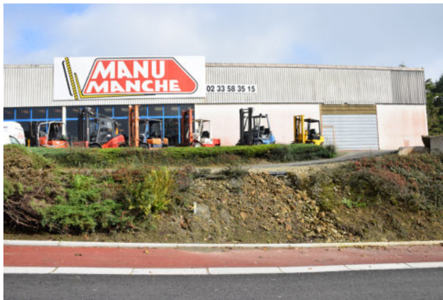
Cas d'architecture et d'abords d'activité à revaloriser
