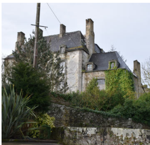
Château de Châteauneuf d'Ille et Vilaine, un patrimoine à réhabiliter
