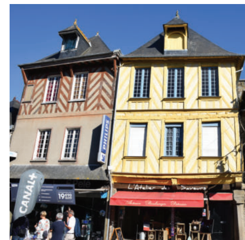
Maisons à pan de bois réhabilitées dans le centre-bourg de Dol-de-Bretagne
