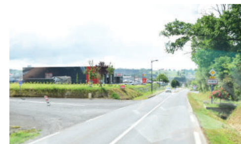
Emprises d'activités le long de la RD, en arrivant à Ponts
