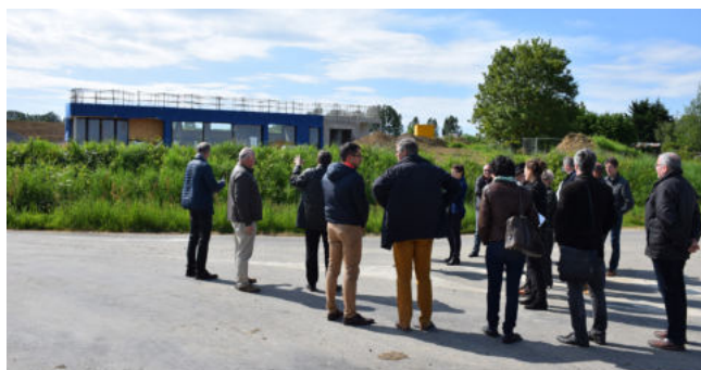
Construction en cours de la maison des marais, lors d'une des journées de lecture du paysage, 14 mai 2018
