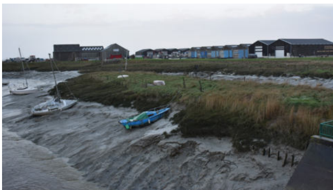
Installations du Port du Vivier-sur-Mer
