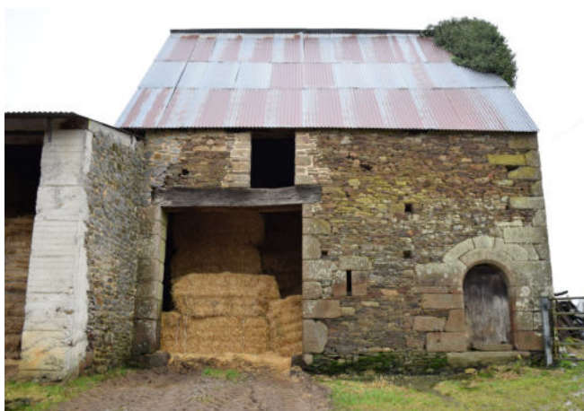
Appareillage en pierre à joints secs et voûte (la Fontenelle)
