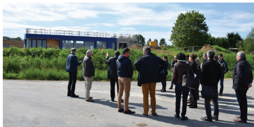
Marais de Sougéal et Maison des Marais en construction
