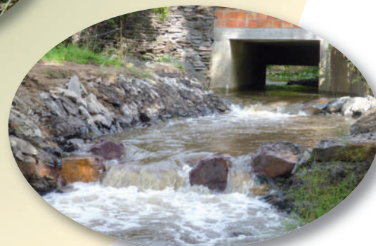
Moulin de Boscher : Pré seuils de franchissement
