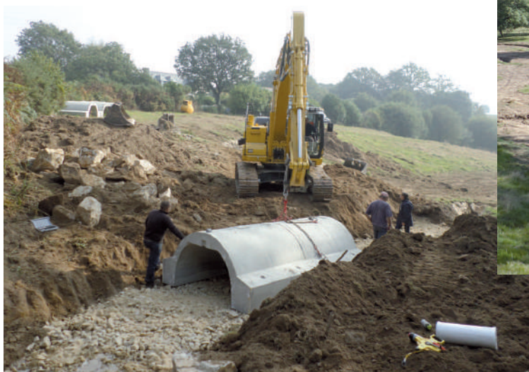
Pose d'une demi-arche permettant le passage d'engins
