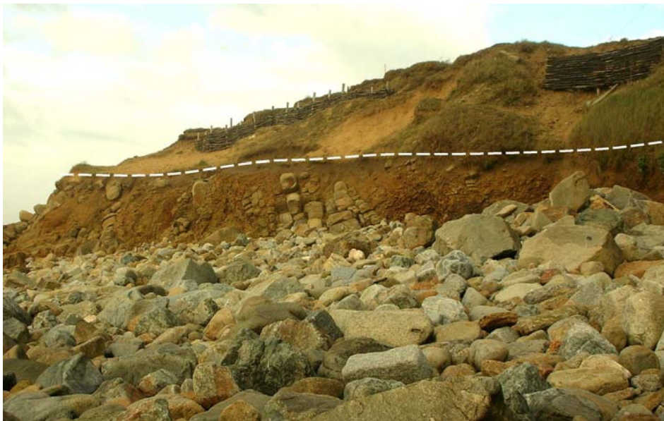
Figure 3. vue générale du nouvel affleurement du Bas-Pouldu (Guidel, 56); estran avec nombreux blocs rocheux rapportés aux fins de protection; falaise vive de microgranite surmontée par la dune équipée de fascines.
