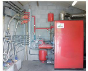
L'installation d'un chauffage central permet de chauffer 3 poulaillers (1200m<sup>2</sup>, 1000m<sup>2</sup> et 600m<sup>2</sup>) et de produire l'eau chaude sanitaire nécessaire à la préparation des buvées des veaux de boucherie (224 places, 1000l par buvée).
