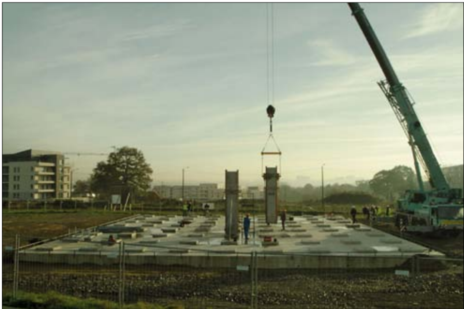
Fig. 8 - Installation et mise en place des monolithes au parc Beauregard, Rennes (La Générale du Granit).
