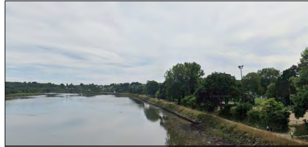
Exemple d'ouvrage linéaire de protection : la digue du halage.
