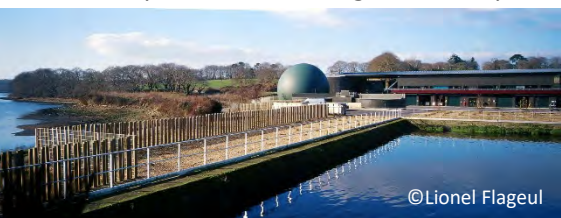
Station d'épuration du Corniguel à Quimper
