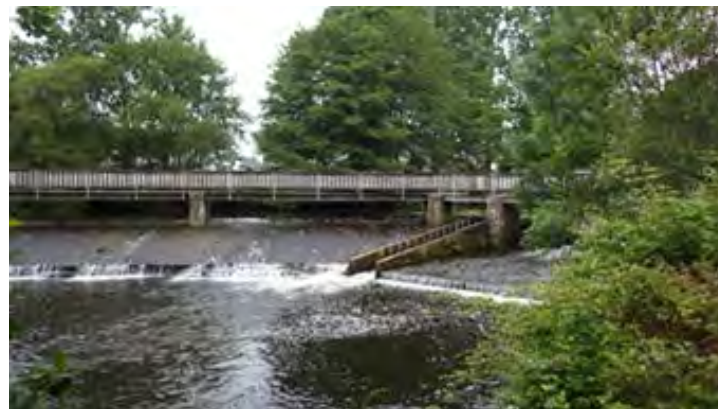
Aval de l'ouvrage
