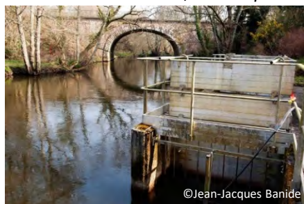
Point de captage d'eau sur le Steir à l'usine de Troheir, à Quimper
