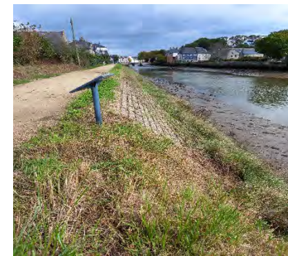
Système d'endiguement du Halage
