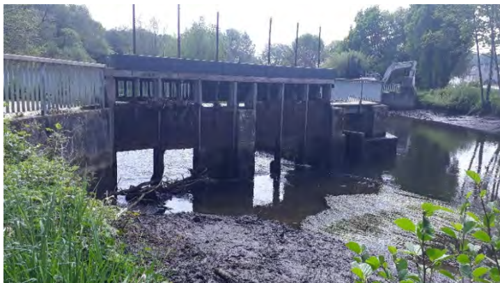
Amont de l'ouvrage
