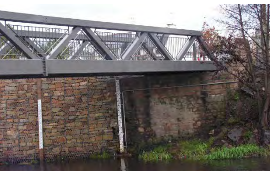
Station limnimétrique de l'Odet à Kervir à Quimper
