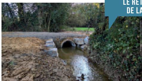
Remplacement d'ouvrage/ Aménagement d'un passage busé (Taupont)
