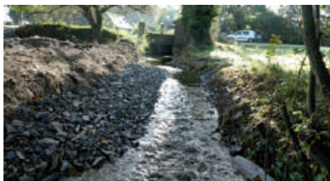
Rampe d'enrochement (Ploërmel)
