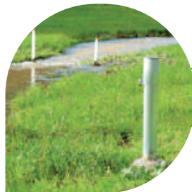
Piezomètres installés sur le site pour suivre l'évolution de la nappe d'eau
