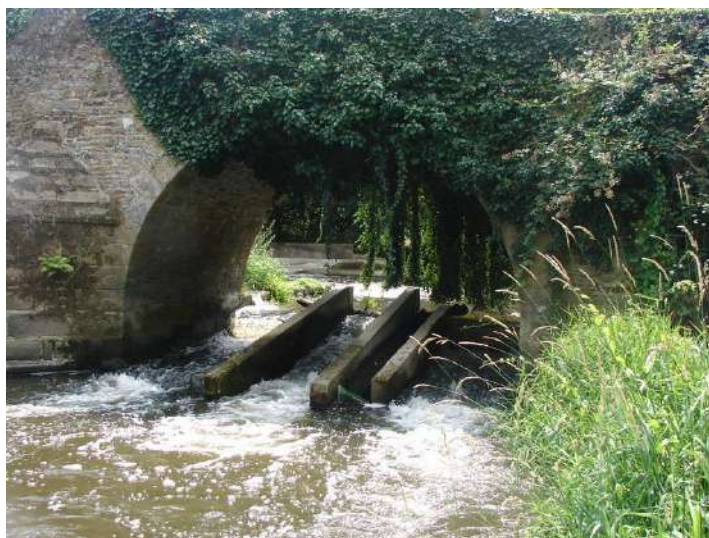
Pose de nouveaux ralentisseurs dans la passe à poissons du seuil du Moulin d'Antrain
