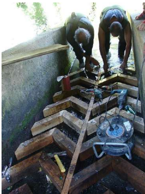
Pose de nouveaux ralentisseurs dans la passe à poissons du seuil du Moulin d'Antrain
