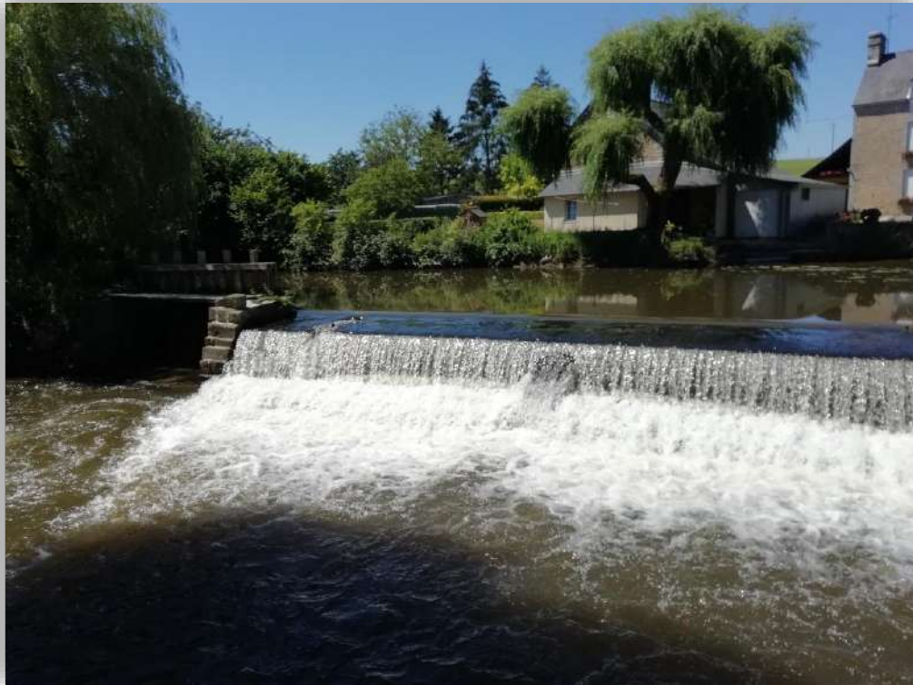
Figure 24 : Barrage de Quincampoix sur le Couesnon (Commune de Rimou)
