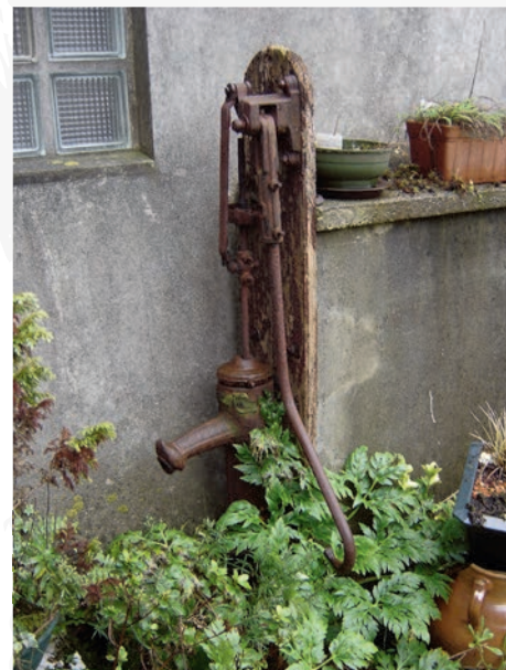
PUITS SANS MARGELLE, RECOUVERT ET ÉQUIPÉ D'UNE POMPE MANUELLE.
