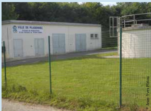
LES EAUX PLUVIALES ENGORGENT LE RÉSEAU.
