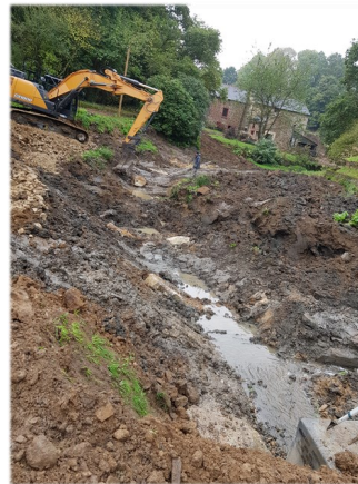
Restauration de cours d'eau sur le bassin versant du Linon (SMBV Linon)
