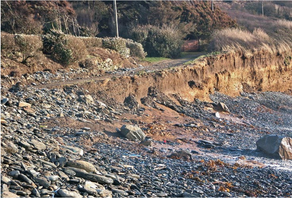
Falaise de lœss à Locquémeau : après la tempête du mars 2008, la falaise n'a pas bougé, mais le cordon de galets à proximité a reculé de plus de 10 m.
