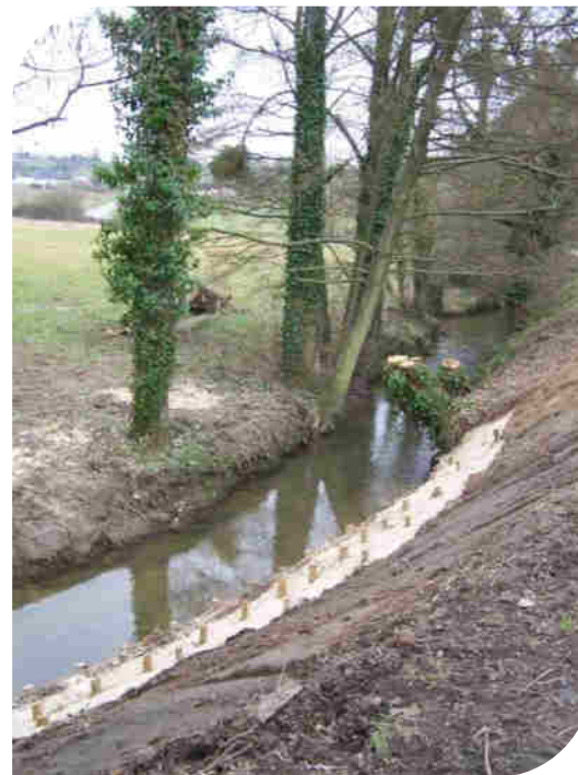
Stabilisation de berge par génie végétal
