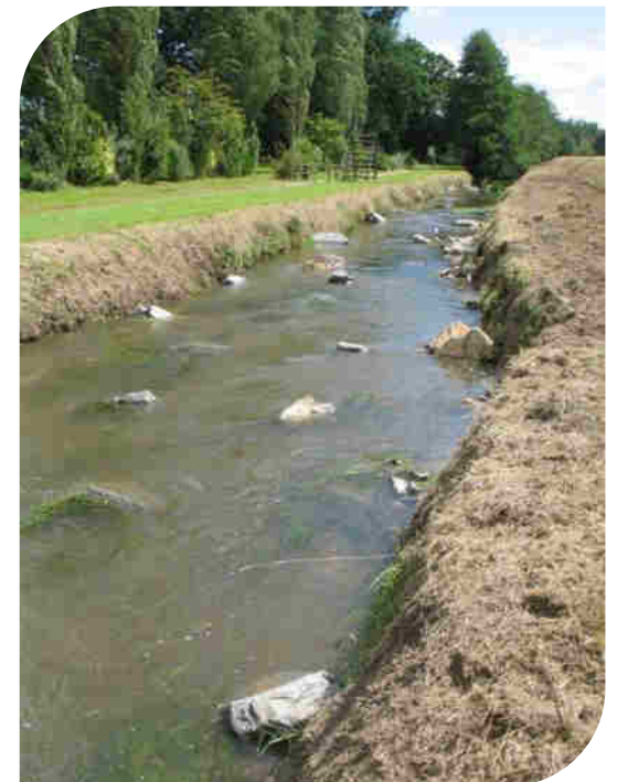
Diversification des écoulements par apport de blocs
