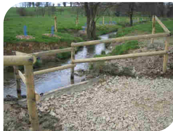
Aménagement d'un abreuvoir
